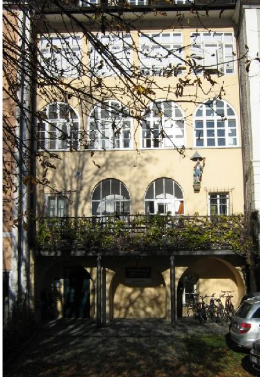
denkmalgeschützten Gebäude der Salzburger Altstadt
